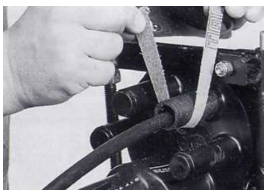
Σχήμα B2.3.38 Προετοιμασία επιφανειών στρογγυλής εισόδου και καλωδίων για τοποθέτηση του θερμοσυστελλόμενου σωλήνα
