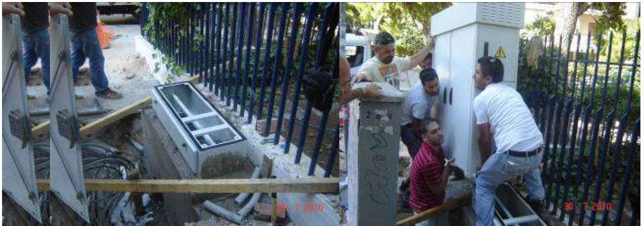
Σχήμα A9.2.17 Αφαίρεση των ξυλοτύπων και τοποθέτηση της καμπίνας στην βάση της
