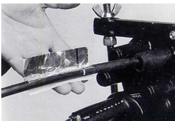
Σχήμα B2.3.39 Τοποθέτηση των φύλλων αλουμινίου
