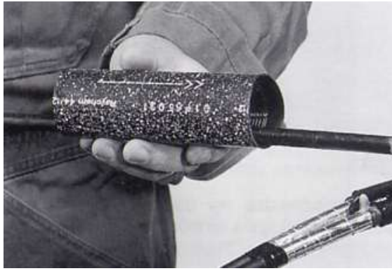
Σχήμα B2.3.34 Πέρασμα στρογγυλού θερμοσυστελλόμενου σωλήνα
