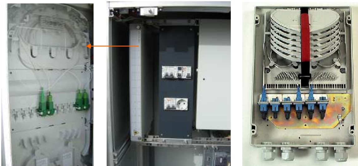
Σχήμα B2.4.4 Οπτικοί κατανομητές στην καμπίνα Γ2 και σε εισαγωγές κτιρίων
