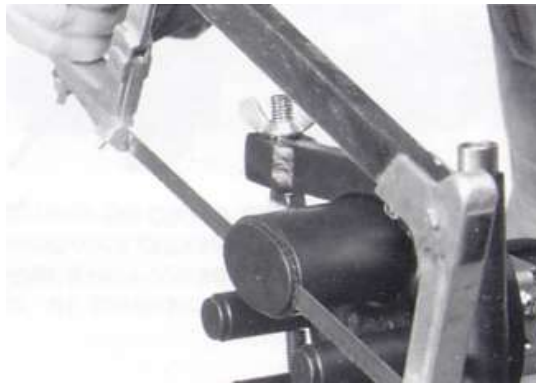
Σχήμα B2.3.3 Άνοιγμα οβάλ άκρου εισόδου καλωδίου του περιβλήματος
