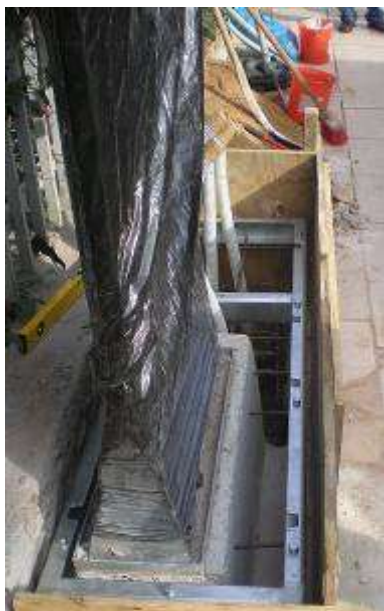
Σχήμα Α9.2.9 Τοποθέτηση ξυλοτύπου, σκυροδέτηση και επανατοποθέτηση μανδύα KV
