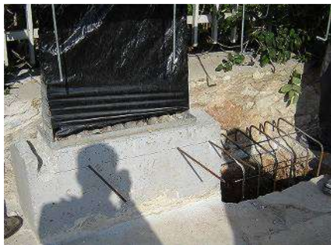
Σχήμα A9.2.7 Προσαρμογή πλαισίου, εκσκαφή τάφρου επέκτασης, τοποθέτηση οπλισμού
