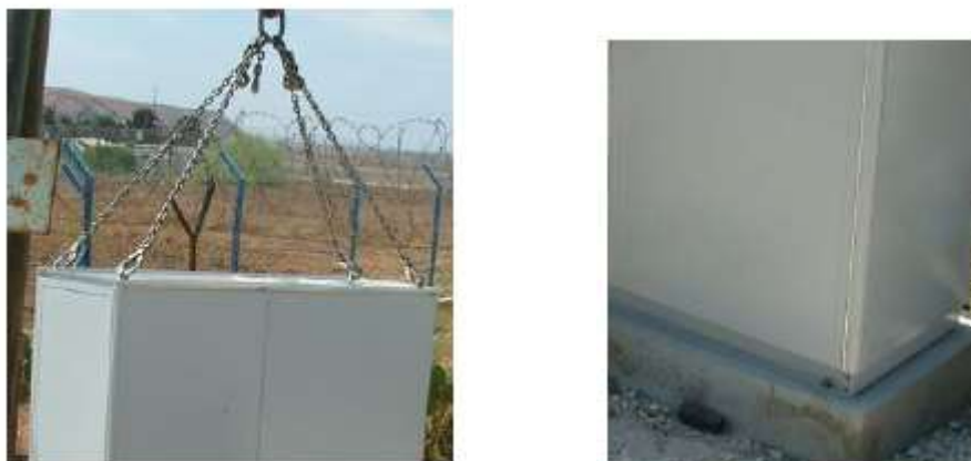
Σχήμα Α.9.3.6 Τοποθέτηση καμπίνας
