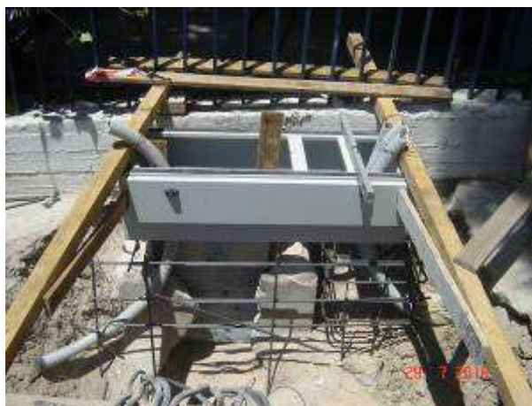
Σχήμα A9.2.14 Τοποθέτηση μεταλλικού πλαισίου και σωλήνων διέλευσης καλωδίων
