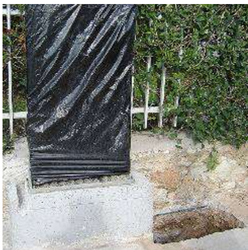
Σχήμα A9.2.7 Προσαρμογή πλαισίου, εκσκαφή τάφρου επέκτασης, τοποθέτηση οπλισμού
