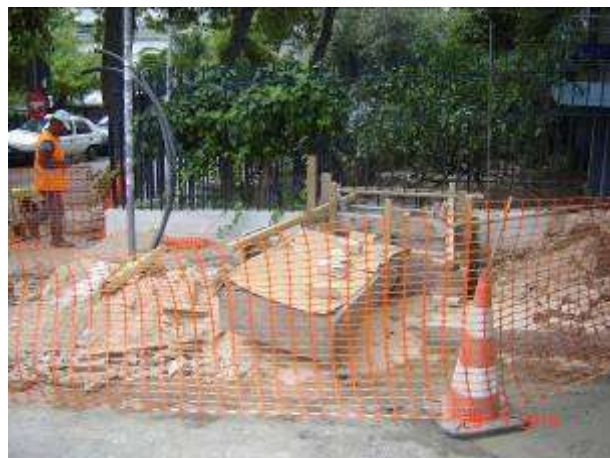
Σχήμα A9.2.15 Τοποθέτηση ξυλοτύπου, σκυροδέτηση και περίφραξη χώρου υφιστάμενου KV
