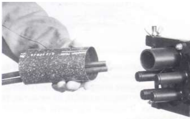
Σχήμα B2.3.4 Τοποθέτηση θερμοσυστελλόμενου σωλήνα
