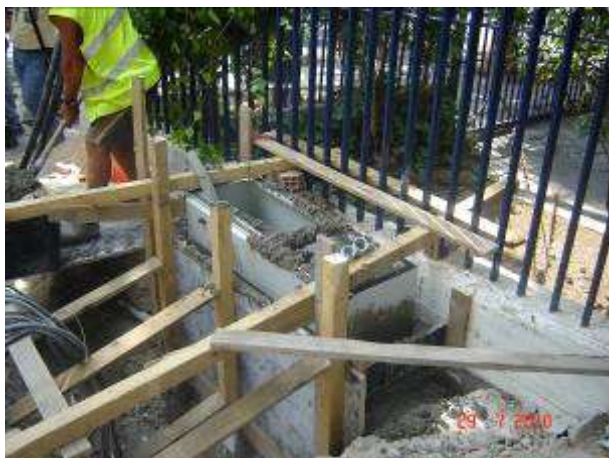
Σχήμα A9.2.15 Τοποθέτηση ξυλοτύπου, σκυροδέτηση και περίφραξη χώρου υφιστάμενου KV
