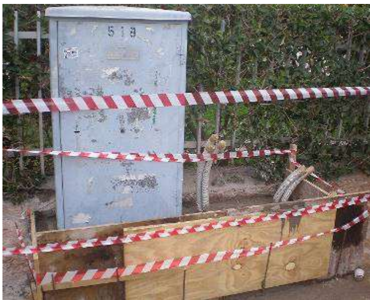
Σχήμα Α9.2.9 Τοποθέτηση ξυλοτύπου, σκυροδέτηση και επανατοποθέτηση μανδύα KV
