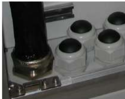
Σχήμα Α.9.1.10 Στυπιοθλίπτες στο εσωτερικό καμπίνας
