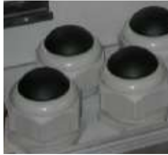
Σχήμα Α.9.3.7 Στυπιοθλίπτες στο εσωτερικό καμπίνας
