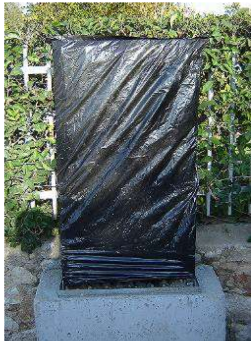
Σχήμα Α9.2.6 Προετοιμασία υφιστάμενου KV – Απομάκρυνση Μανδύα και Κάλυψη Κατανεμητή
